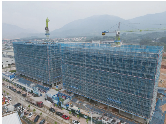
位于华安经济开发区北部片区的邻里中心项目施工现场
